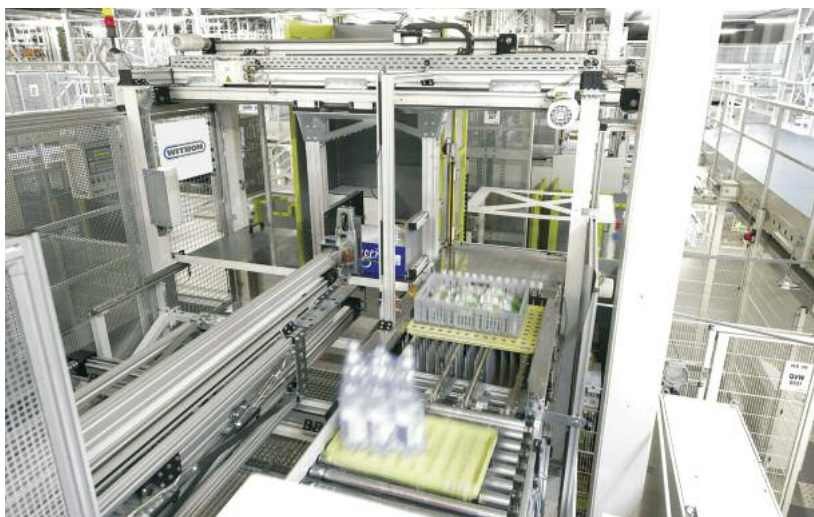
Die OPM-Anlage von Witron kommissioniert vollautomatisch über 500 Picks pro Stunde Handelseinheiten produktschonend auf Ladungsträger
